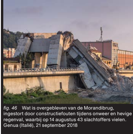
fig. 46 Wat is overgebleven van de Morandibrug, ingestort door constructiefouten tijdens onweer en hevige regenval, waarbij op 14 augustus 43 slachtoffers vielen. Genua (Italië), 21 september 2018
